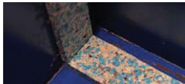
Stap 1a: Agglomer dilatatiestreek op 25 mm van de wand afgeplakt.
