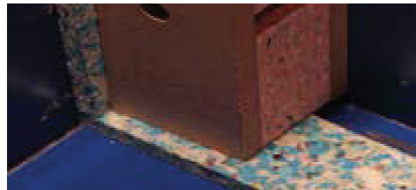
Stap 2a: Plaats de eerste Merfoflex-regel strak in de hoek.
